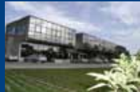
Ebara Pumps Europe S.p.A., ITÁLIA
